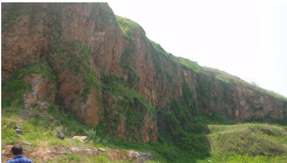
照片 2-11 团粒喷播后的采坑边坡
